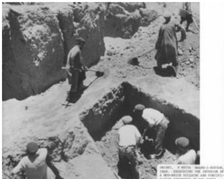
عکس ۳، چند دیوار کهن برجیده شده از استحکامات ایلامی جنوب و غرب مکعب، که در حال حاضر وجود ندارد
